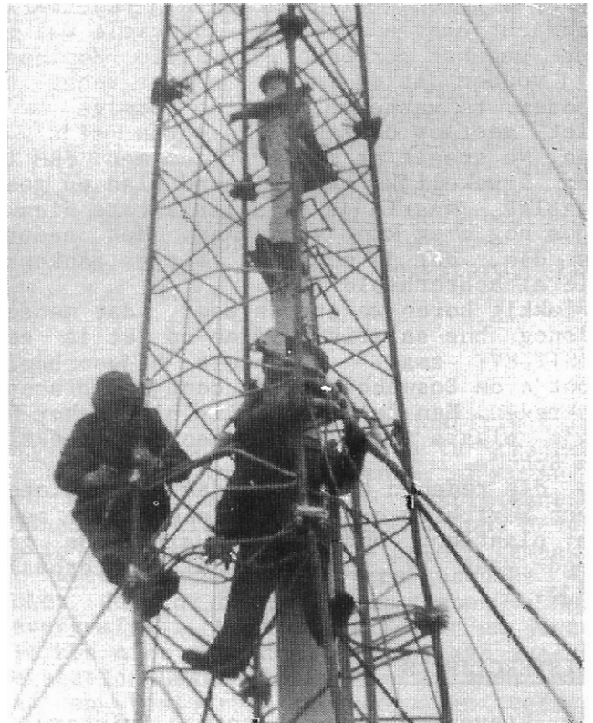
Installatie van de zendmast
