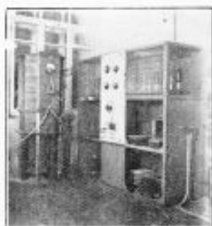
Transmitter at „Maly Komintern” Power 1.2 kW.
